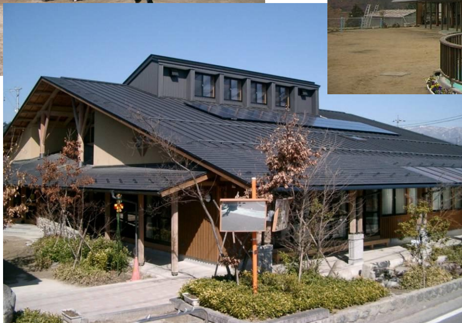
松尾児童クラブに設置された 太陽光発電設備
