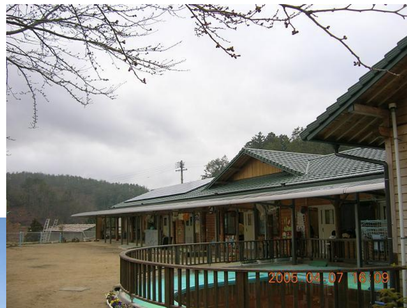
千代保育園に設置された 太陽光発電設備
