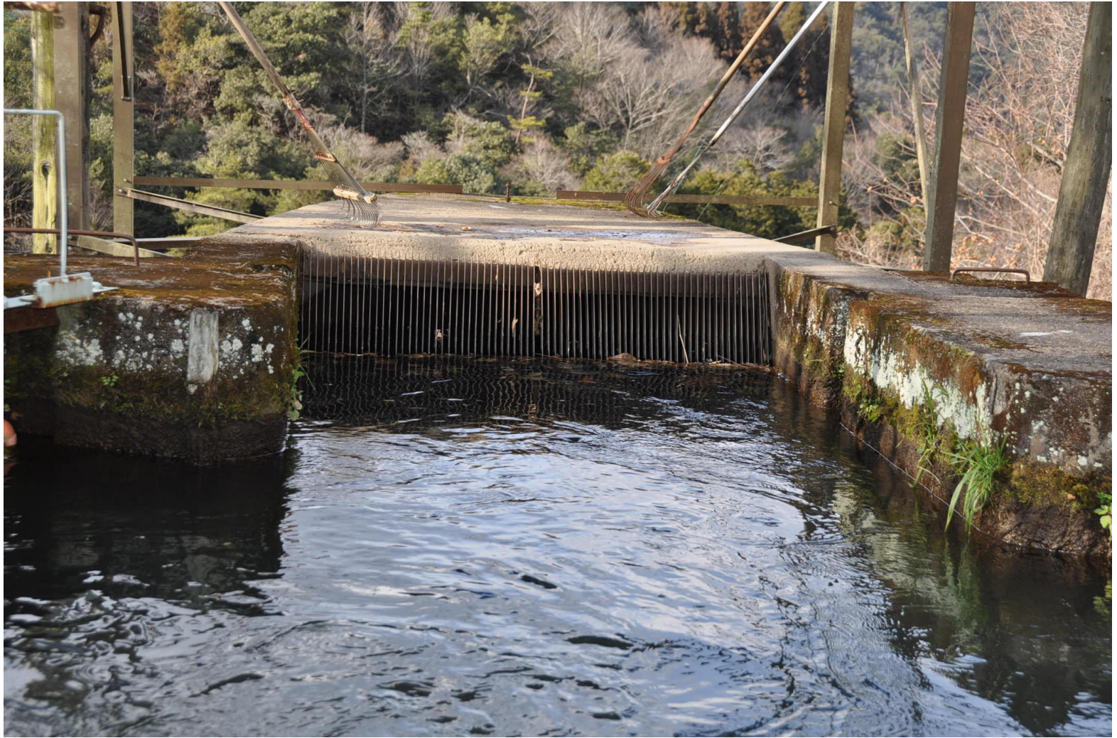
志和堀発電所の水路の終点
