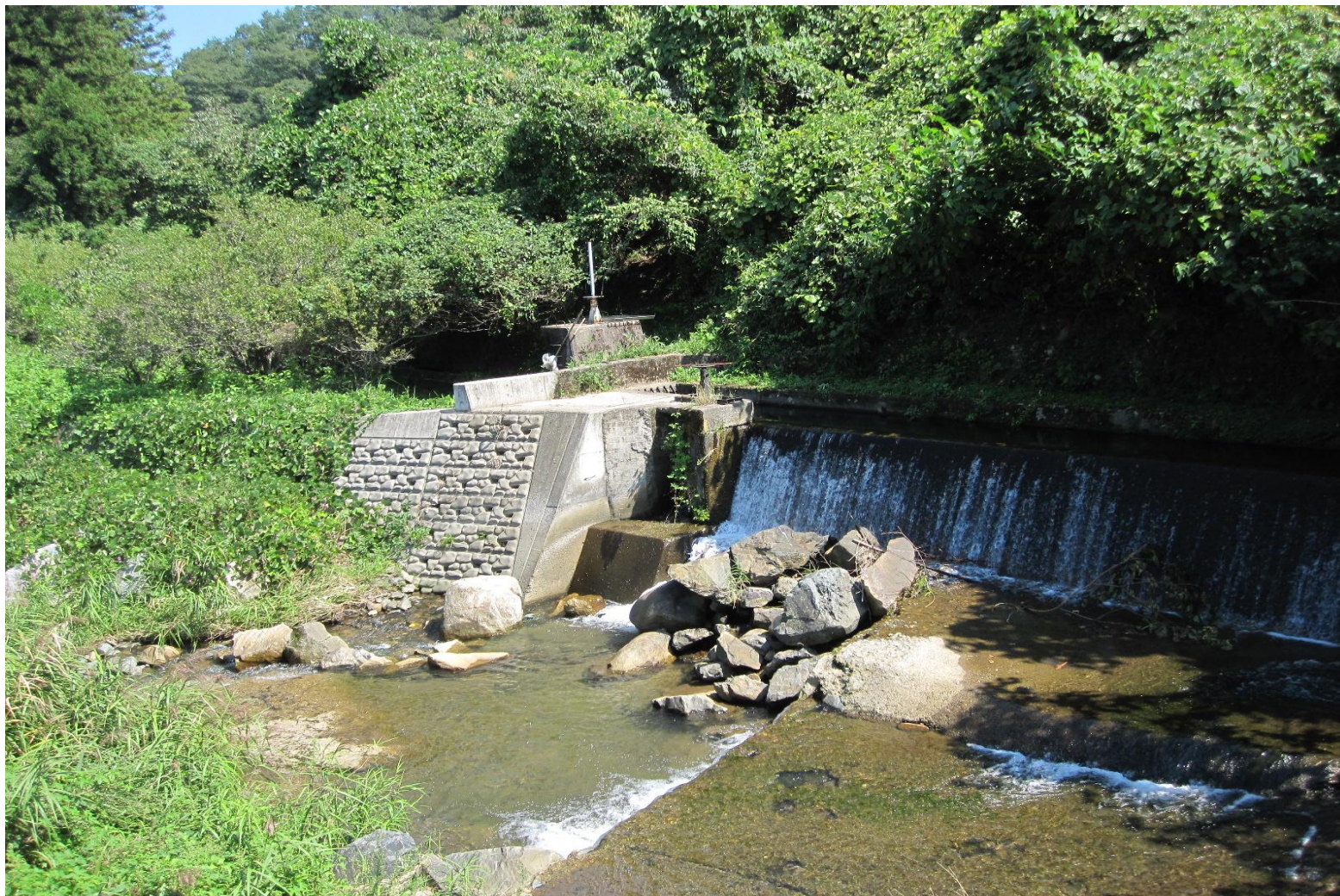
砂谷発電所の取水口の様子
