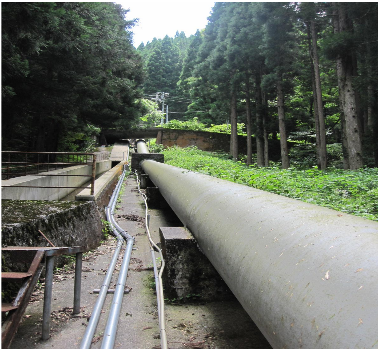
吉和発電所の補助事業により改修された水圧鉄管
