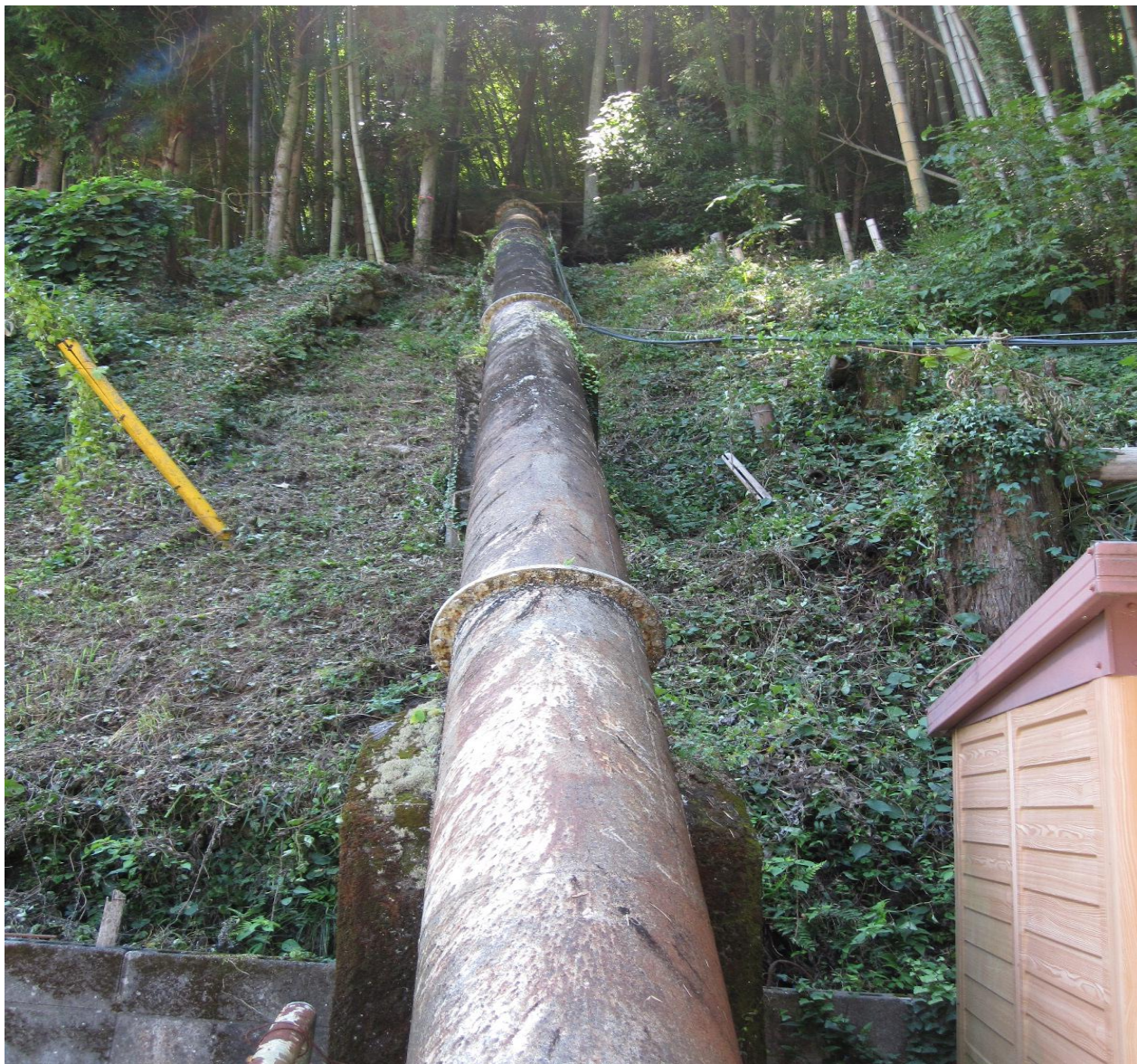
50年以上経過した水圧鉄管(JA広島市:砂谷発電所)
